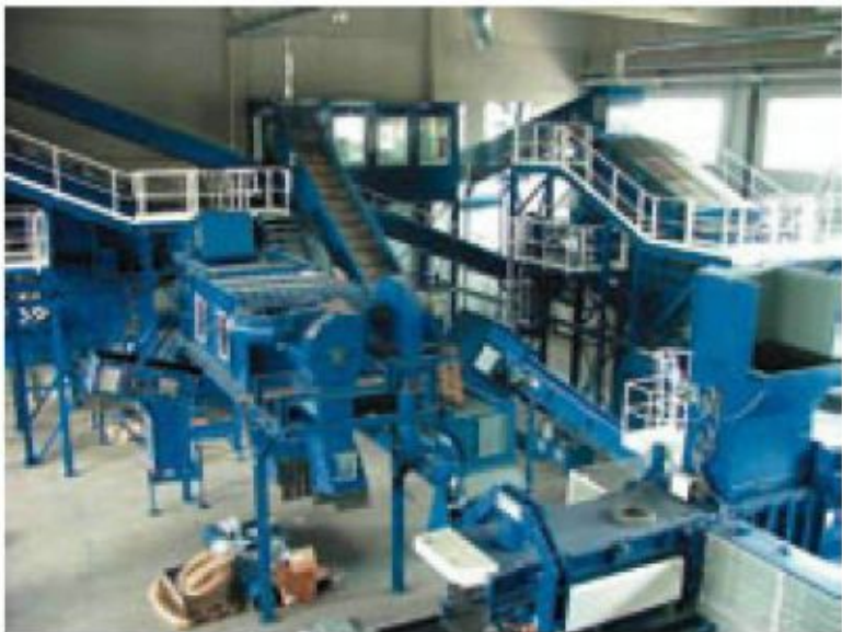
... вид цеха установки в Браунсбедре в Саксонии
